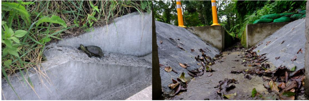
圖 31 逃生坡道坡面增加粗糙度與摩擦力示意圖
