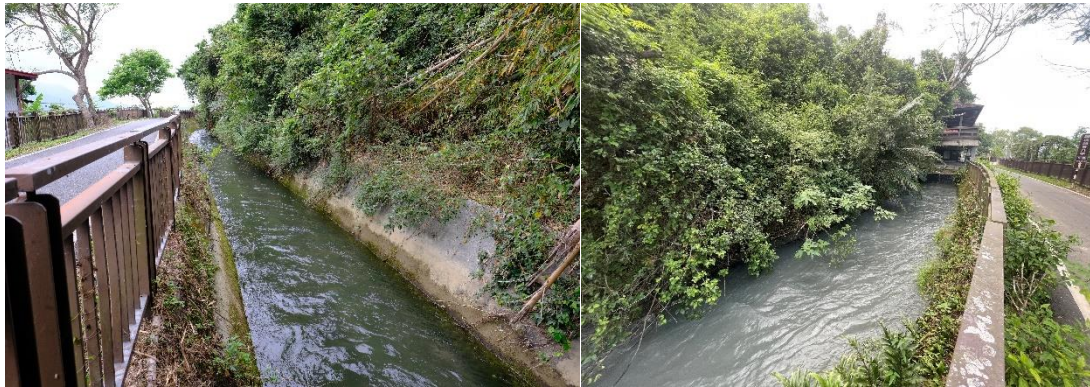
圖 18 關山圳關山自行車道圳段現況
