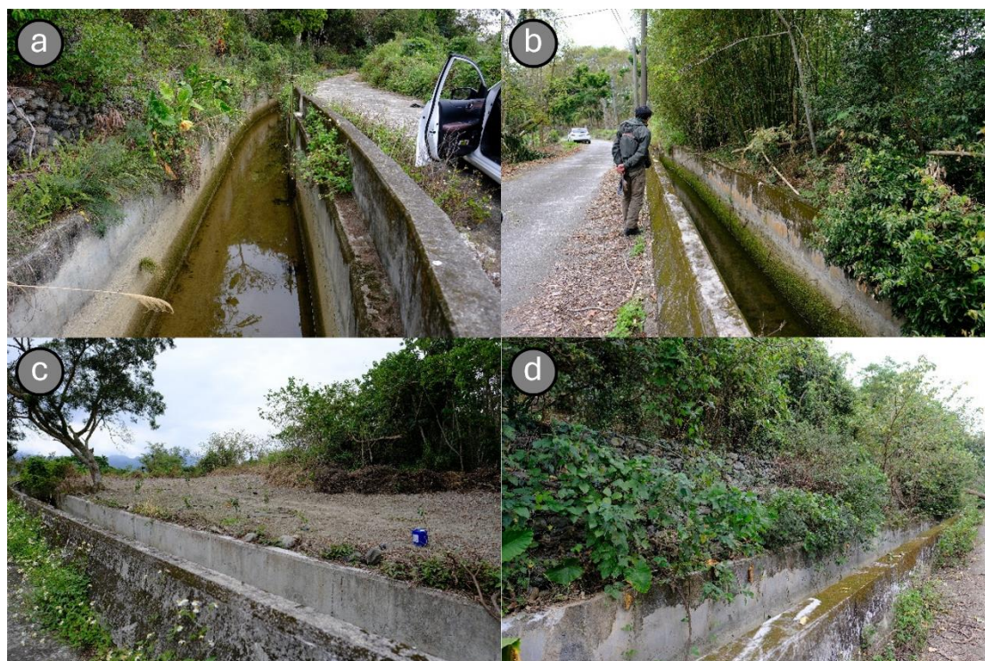
圖 16 關山圳崁頂溪至加鹿溪圳段現況
