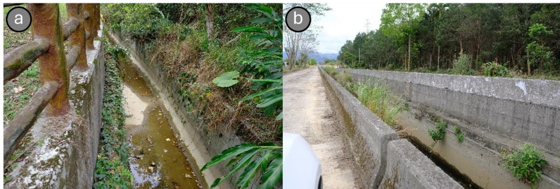
圖 14 關山圳鹿野鄉新豐北側圳段現況
