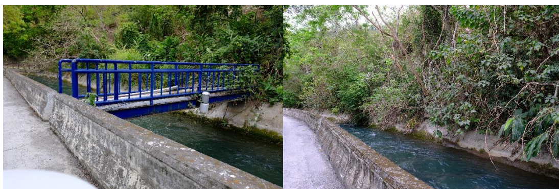
圖 24 關山圳水力發電廠圳路現況
