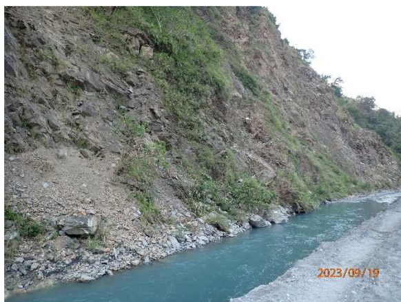
說明：導水流路經過崩塌地
